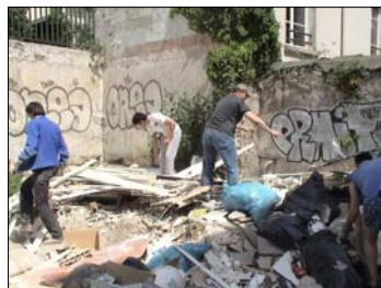
Déblaiement collectif des gravats produits par les aménagements des logements
